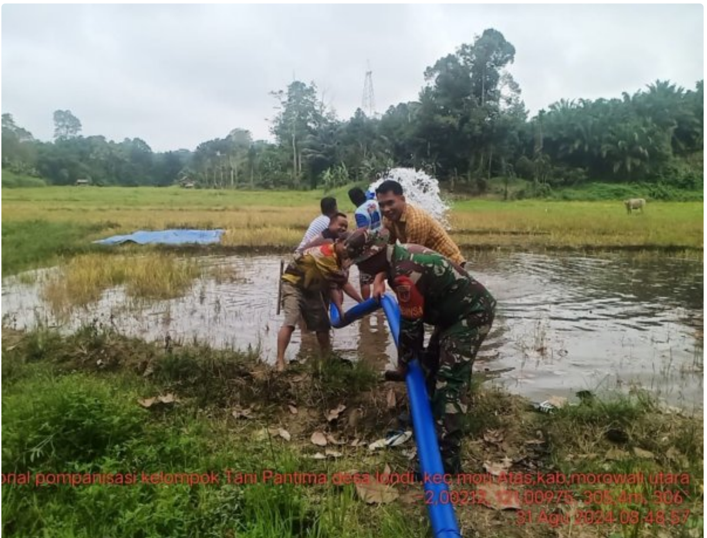
Serka Nasruddin bantu pendampingan pemasangan pompanisasi
