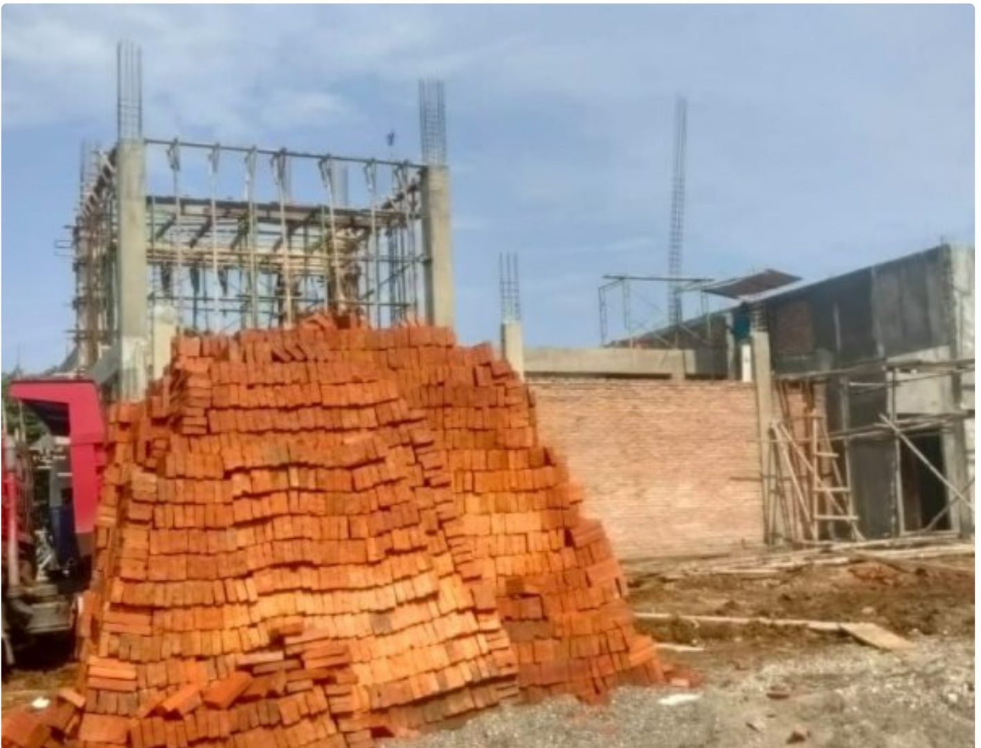
Tampak Pembangunan Kantor Inspektorat Morowali sedang berlangsung
