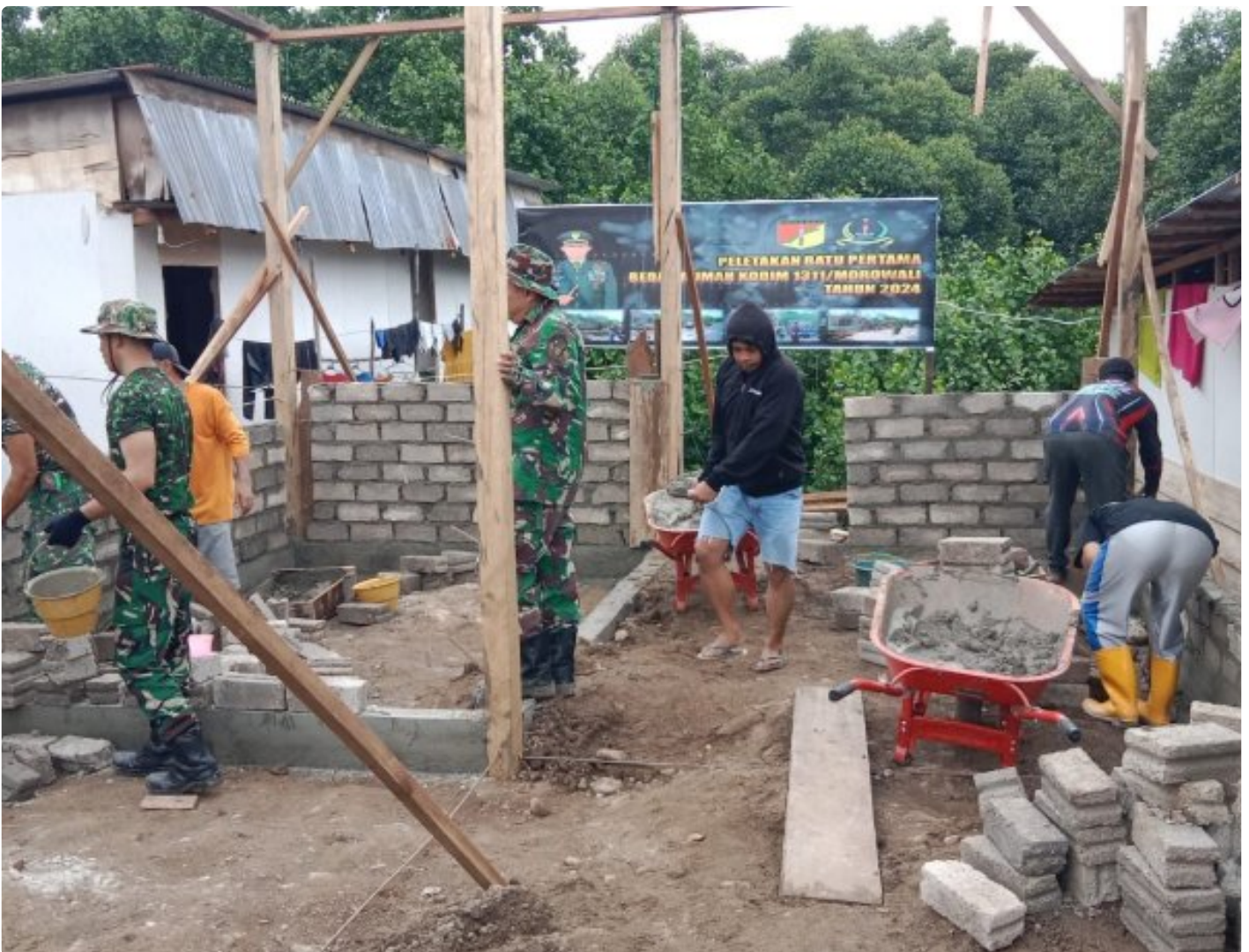
Tampak pengerjaan bedah rumah tahap pemasangan Batako
