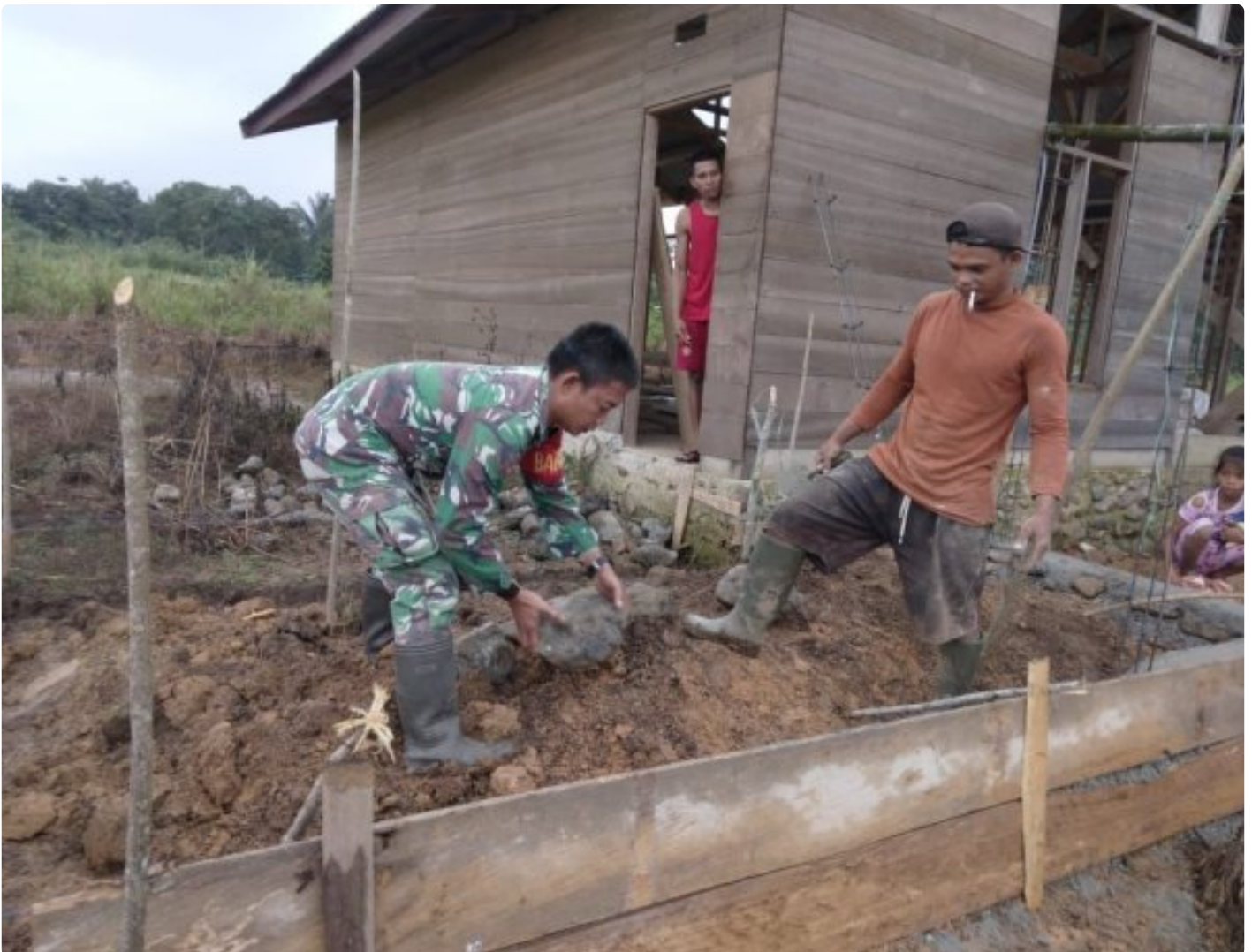
Serda Nonong bantu kerja pondasi rumah warga
